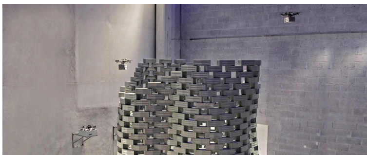
Figura 1.19: VANT construyendo una torre
