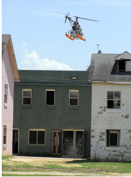
Figura 1.22: VANT inspeccionando un edificio en IARC
